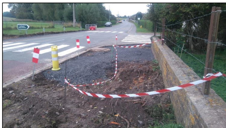
Aménagement de l'accès à l'arrêt de bus rue d'Arras". " Cela fait suite aux alertes et demandes de Riviérois de la rue d'Arras pour les collégiens, lycéens qui prennent le bus." "Merci à ces Riviérois."
