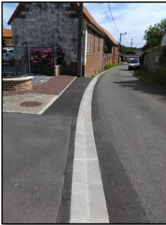
Des travaux voirie ont été menés rue Cagin pour l'écoulement des eaux pluviales. Une bordure franchissable et un enrobé ont été réalisés.
