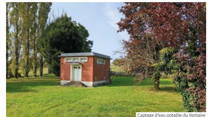
Captage d'eau potable du Venteire
